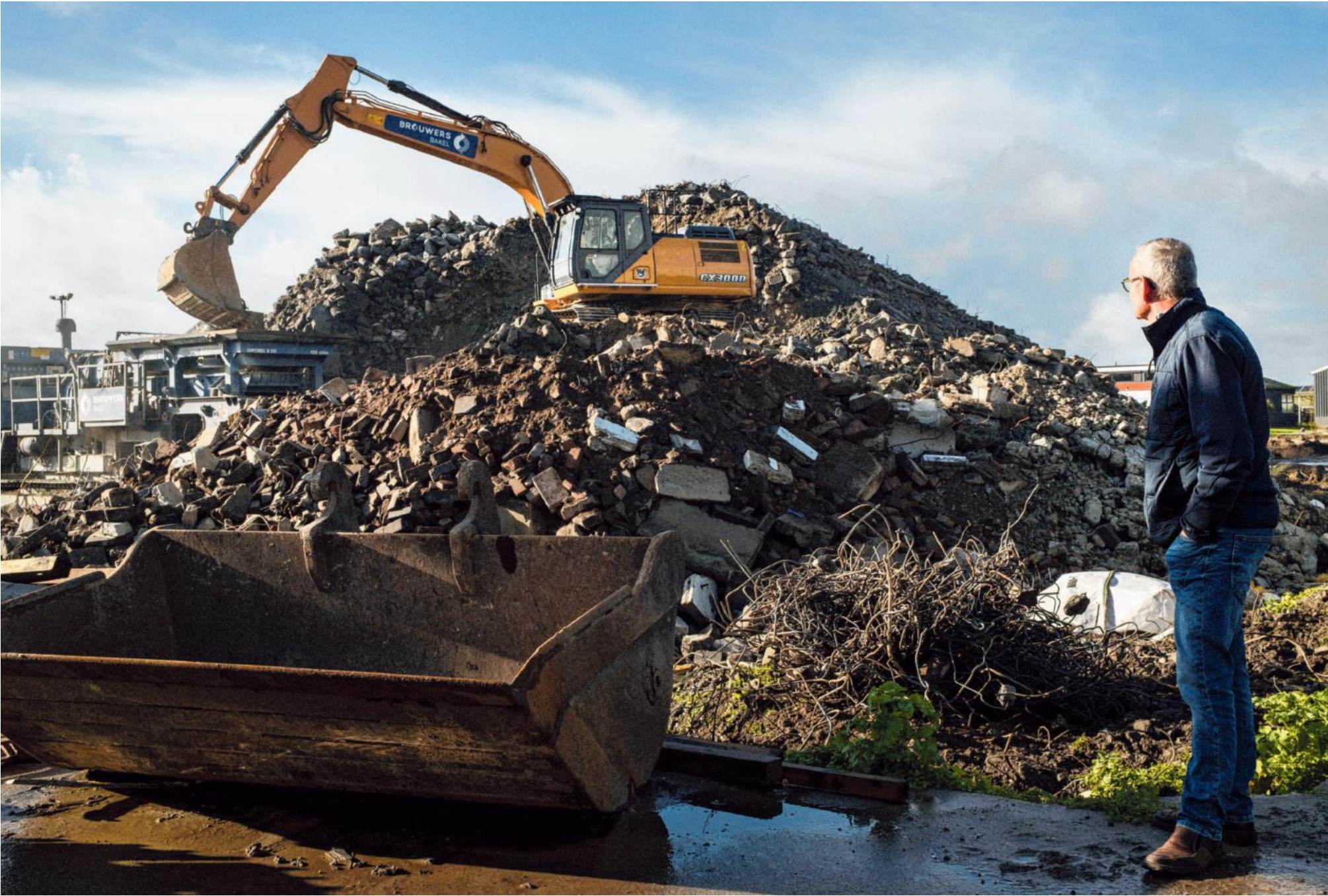
Gepensioneerd melkveehouder Toon van Hoof slaat sloopwerkzaamheden gade. In de Peel zijn veel boerderijen opgekocht met de opkoopregeling.
