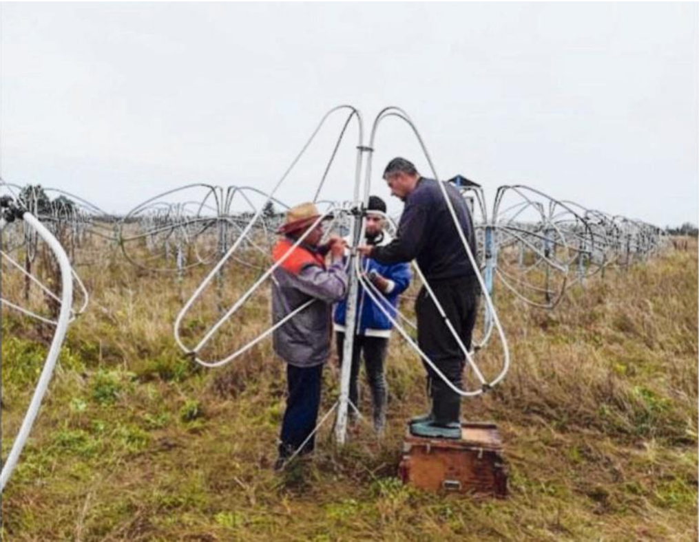
Herstelwerk aan de antennes van radiotelescoop GURT (Giant Ukrainian Radio Telescope) in Charkiv, die beschadigd waren door beschietingen. FOTO VYACHESLAV ZAKHARENKO
