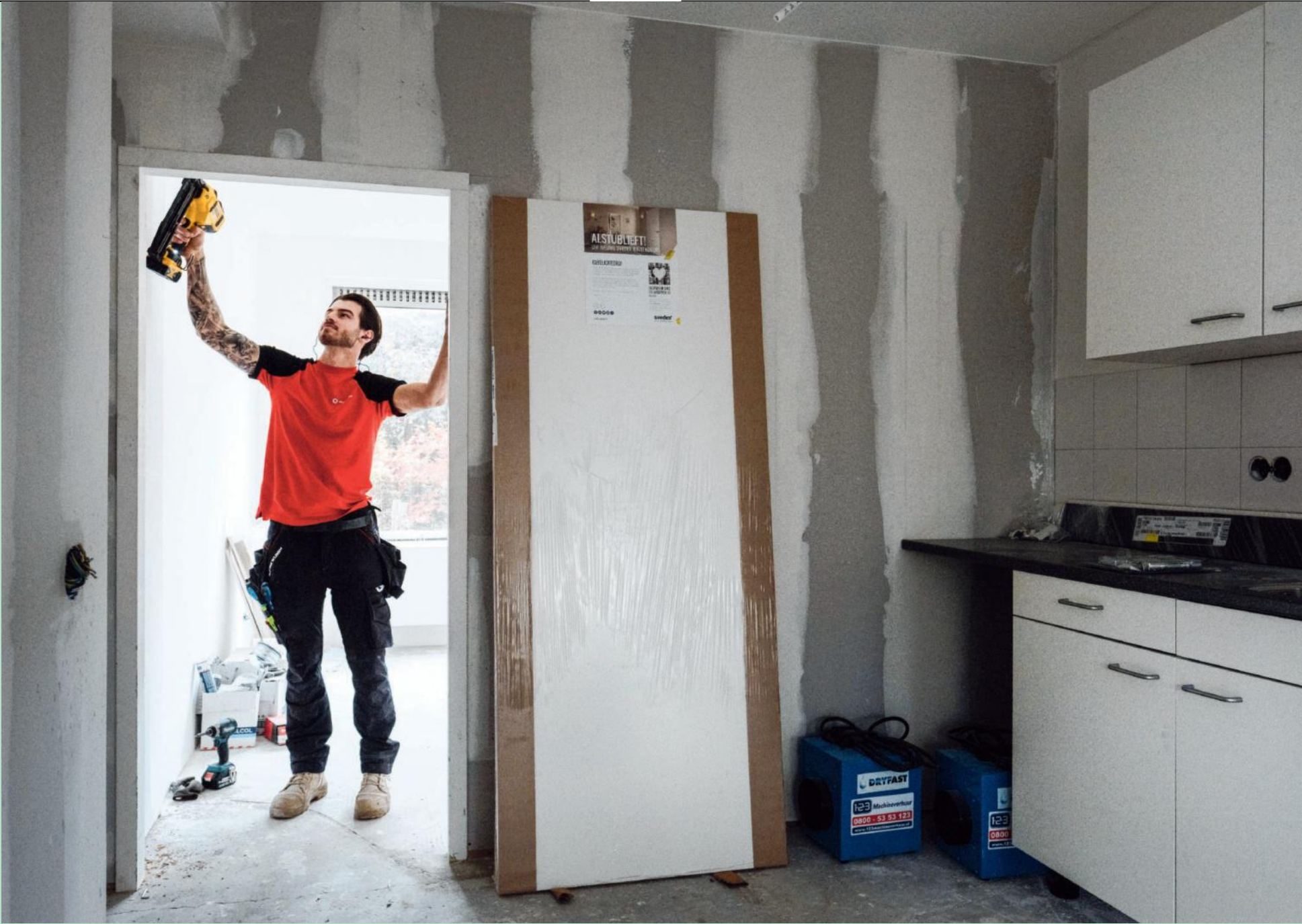
In Den Bosch worden sociale woningen opgesplitst. FOTO MERLIN DALEMAN
