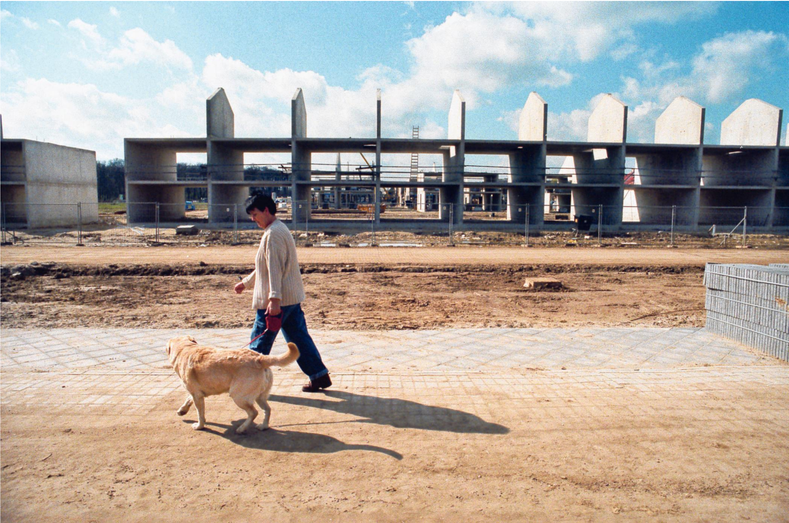
Huizen in aanbouw in Nijmegen in 2002, een jaar nadat de periode waarin je de hypotheekrente van de belasting mocht aftrekken werd beperkt tot dertig jaar. FOTO FLIP FRANSSSEN / ANP
