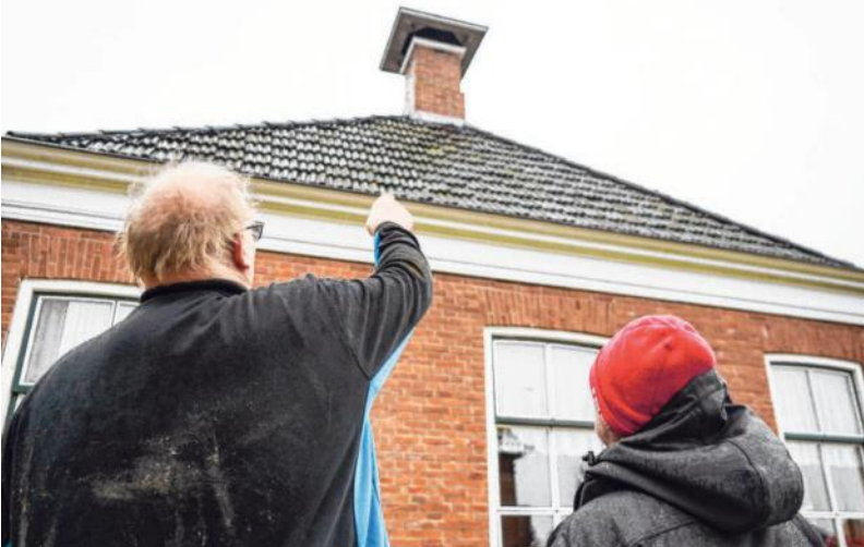
Omstanders kijken in Zeerijp naar schade die de aardbeving heeft veroorzaakt. Foto: RUBEN HUISMAN/ANP/PERSBUREAU METER
