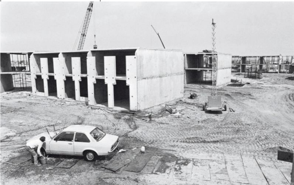
Almere in aanbouw in 1976. FOTO'S ROB MIEREMET/NATIONAAL ARCHIEF
