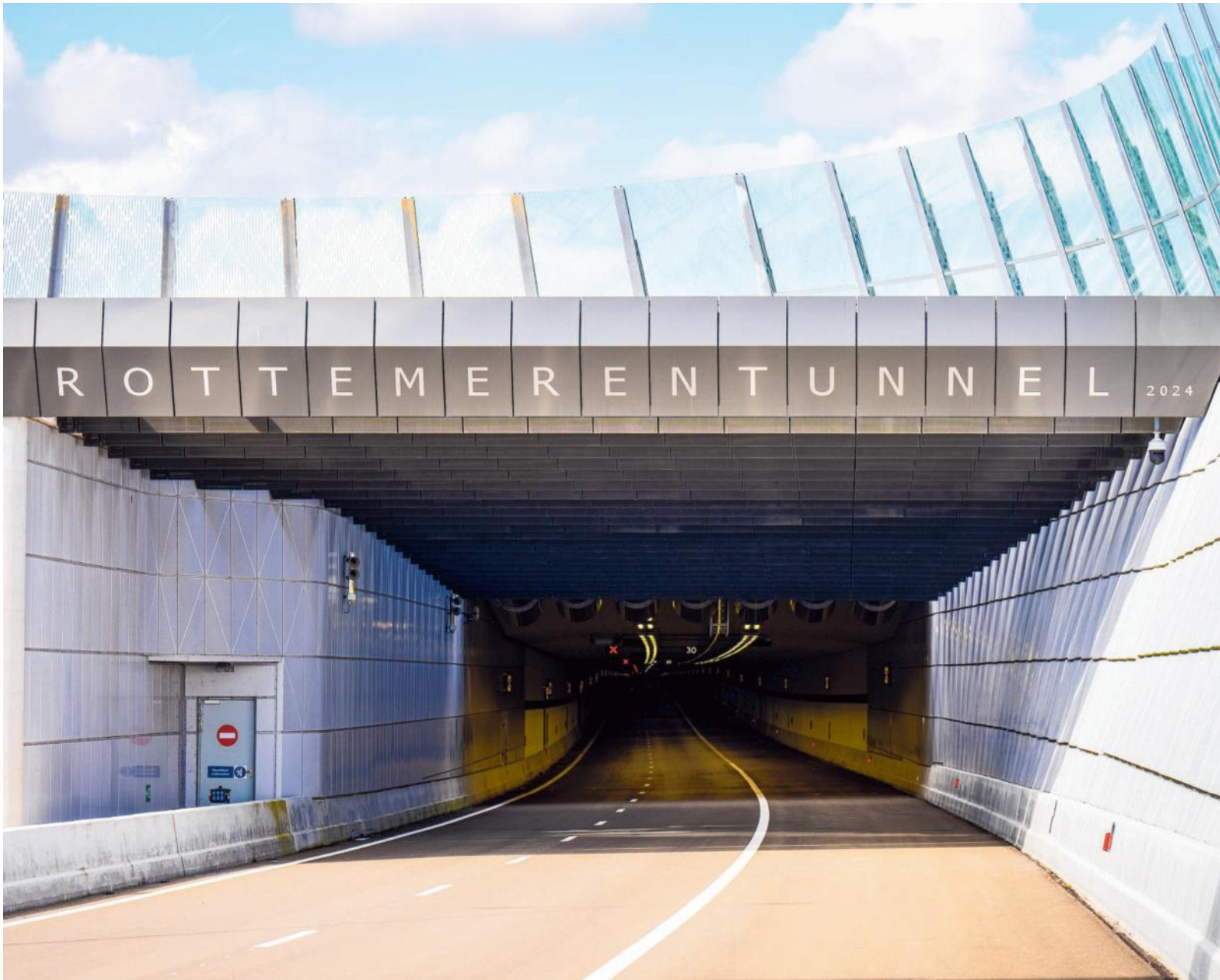
De ingang van de Rottemertunnel op de A16 Rotterdam. FOTO ANP
