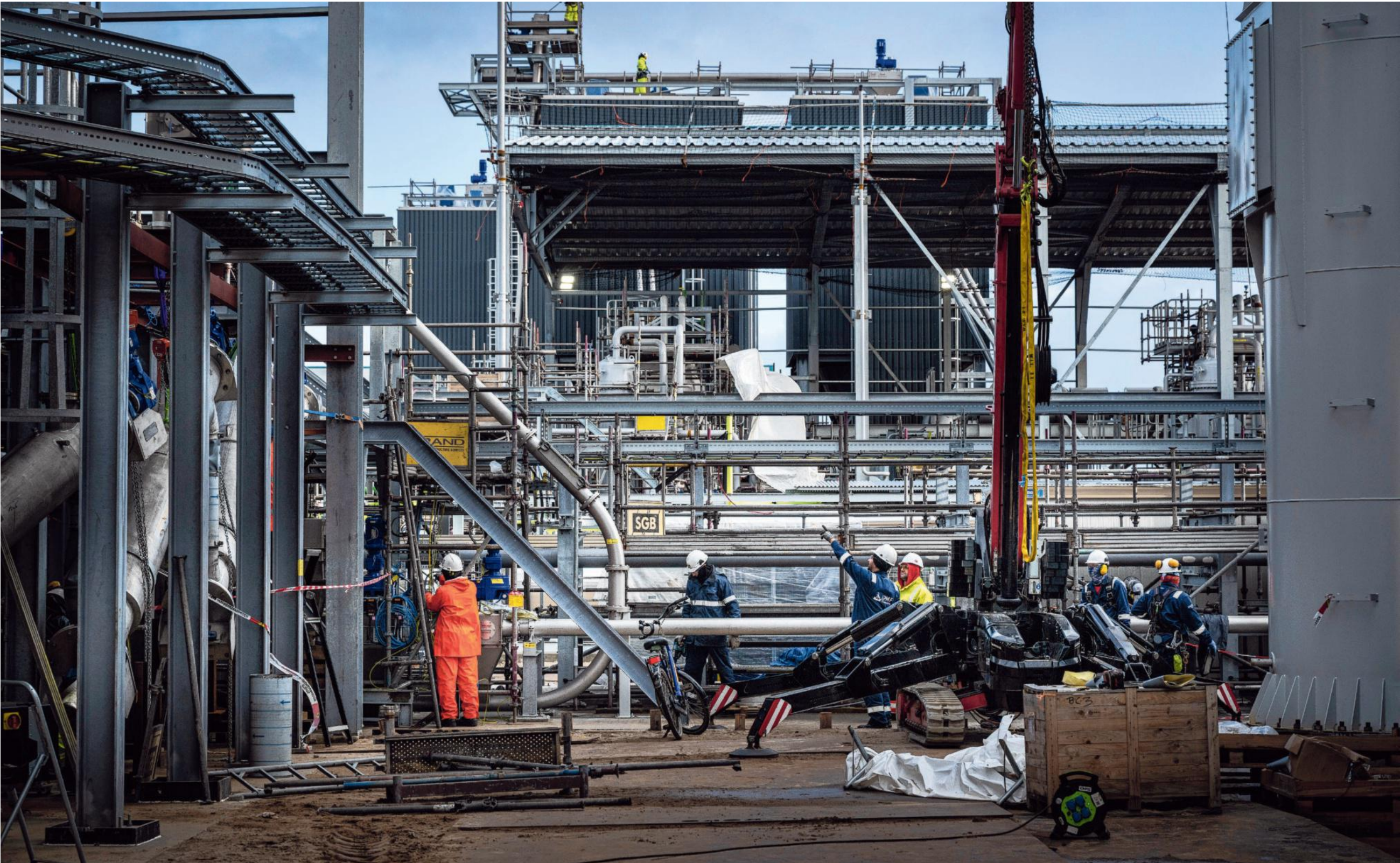
Bouw van de nieuwe fabriek van Cirtec op Chemiepark Delfzijl waarin oude autobanden worden gerecycled.
