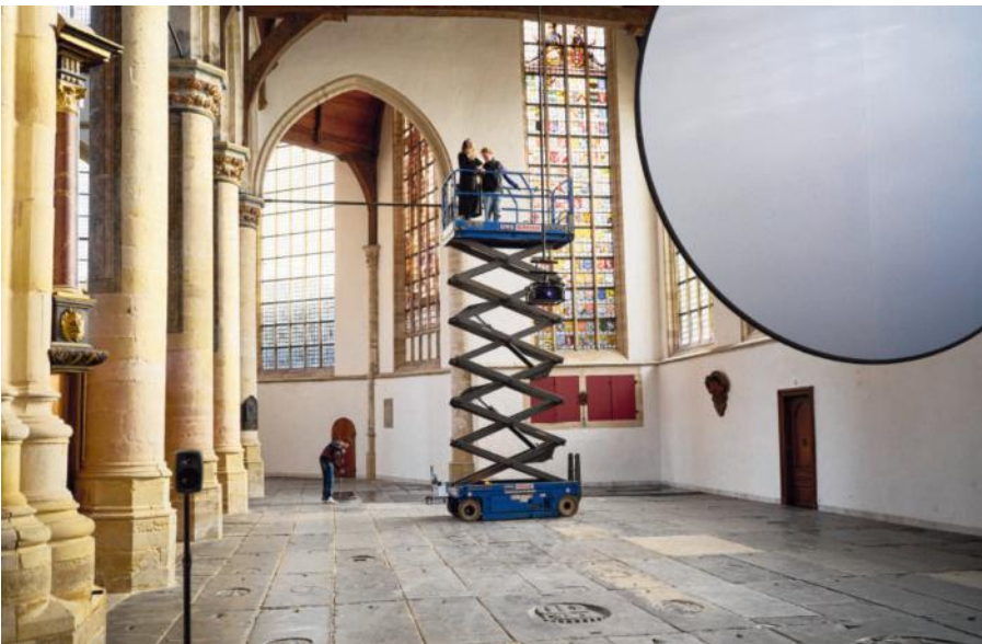
Met de hoogwerker kabels aanleggen over de plafondbalk- en van de kerk voor 'There's Always Ano- ther Twist'. FOTO RO- GER CREMERS
