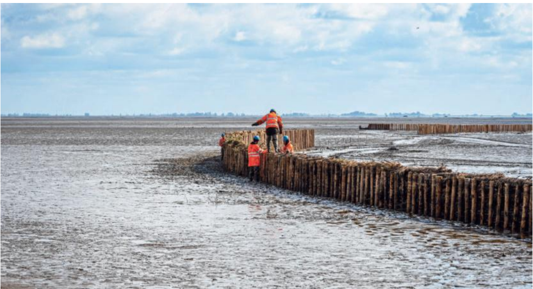
Werkzaamheden aan de Dollarddijk in Groningen. FOTO WALTER HERFST
