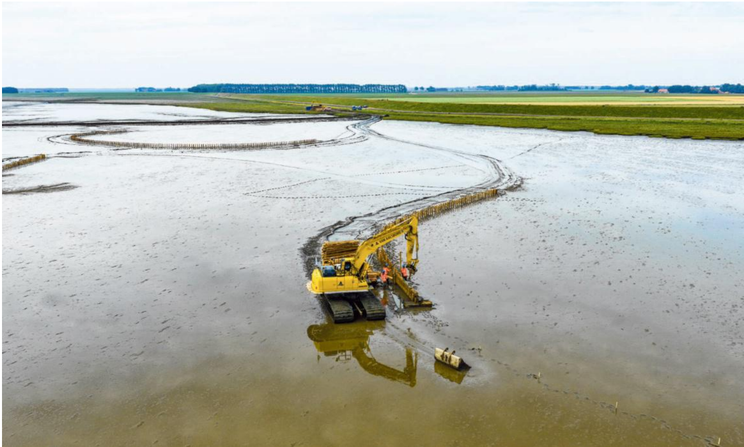
Een graafmachine is bezig met buitendijkse slibsedimentatie bij Termunten. FOTO HOLLANDLUCHTFOTO
