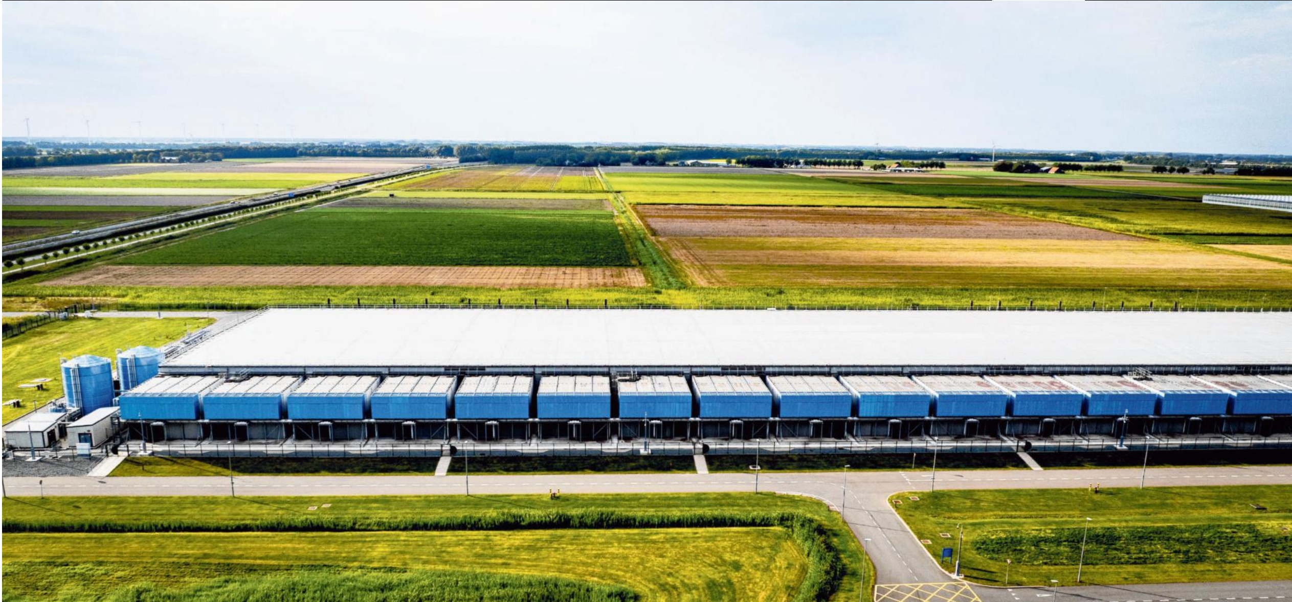
Een Google-datacenter in Middenmeer. FOTO ROBIN UTRECHT/ANP
