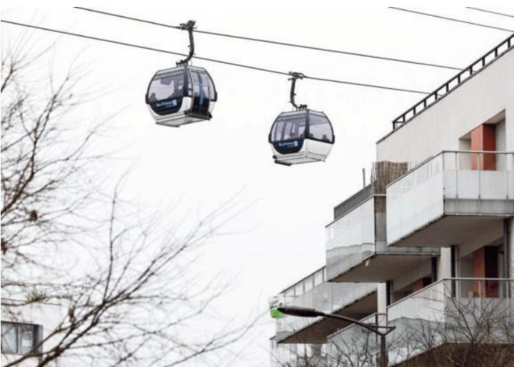
Kabelbaan C1 tijdens de officiële opening. De onderkant van de cabines is ondoorzichtig, voor de privacy van de woningen. FOTO THOMAS SAMSON/AFP
