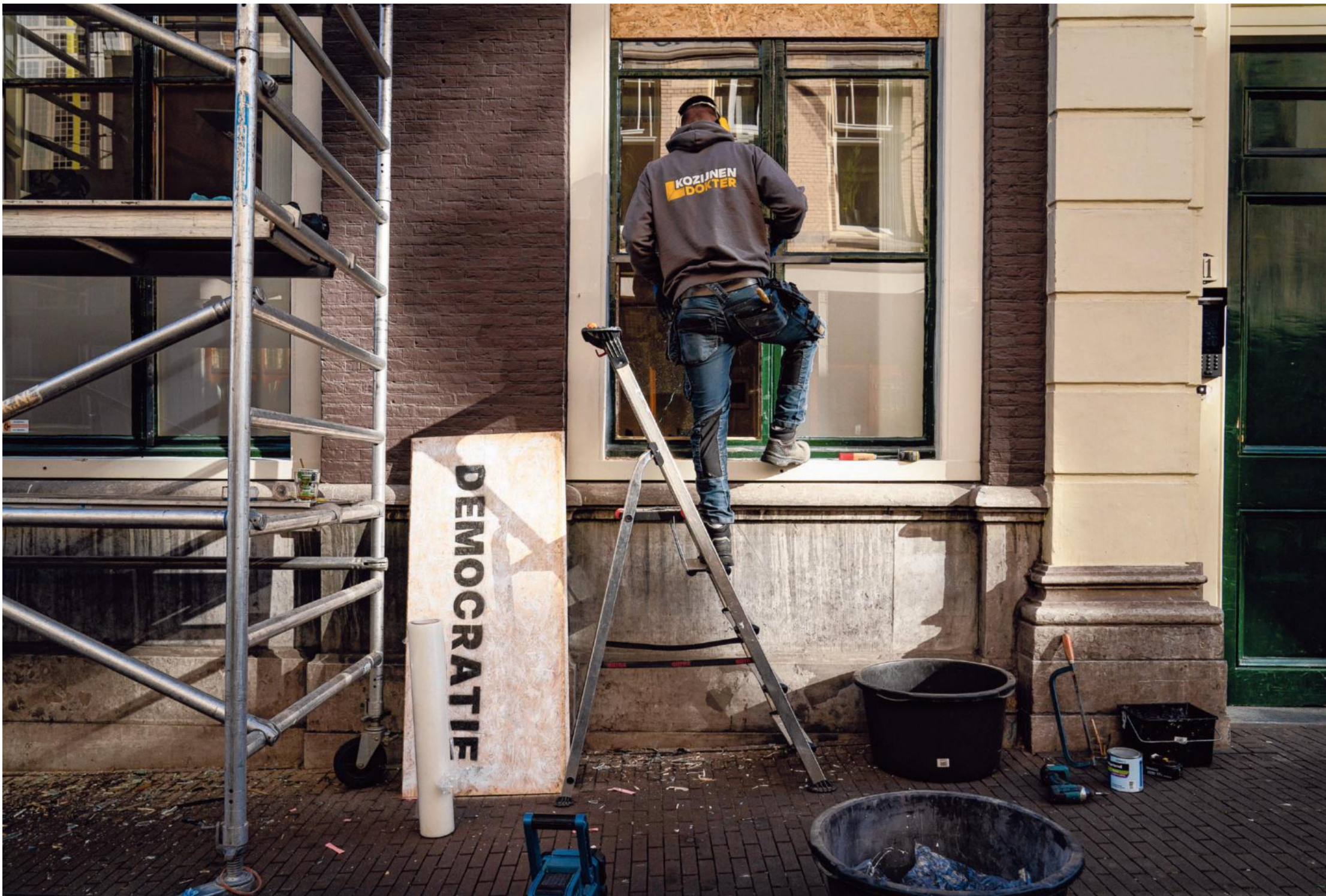
Bij het partijkantoor van D66 worden ruiten vervangen die in september werden ingegooid tijdens rellen in Den Haag. De rellen ontstonden na een uit de hand gelopen demonstratie tegen het asielbeleid. FOTO BART MAAT
