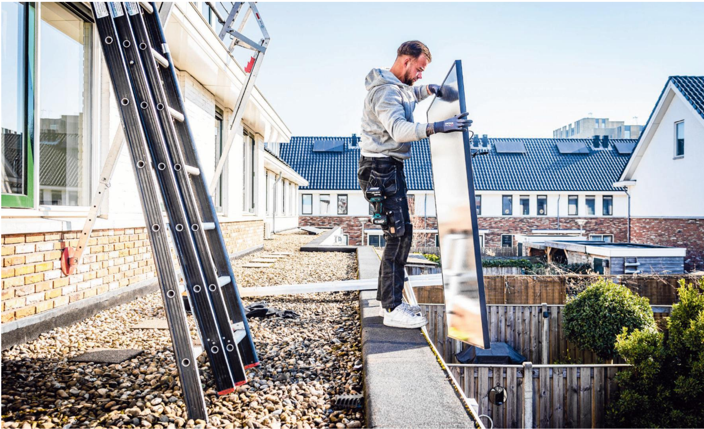
Installatie van zonnepanelen op een dak in Vlaardingen. FOTO JEFFREY GROENEWEG/ANP
