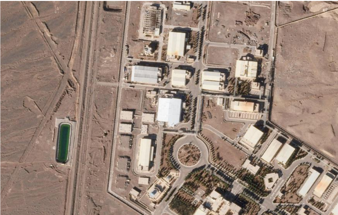
Nieuw dak (onder) op een Iraanse uraniumverrijkingsfaciliteit , die vorig jaar beschadigd werd (boven) door Israëlische bommen. FOTO REUTERS
