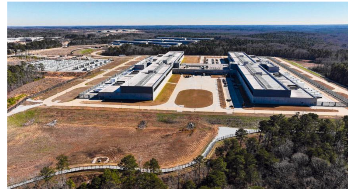
Het Stanton Springs-datacenter van Meta in Newton County, dicht bij Atlanta. FOTO MIKE STEWART/AP
