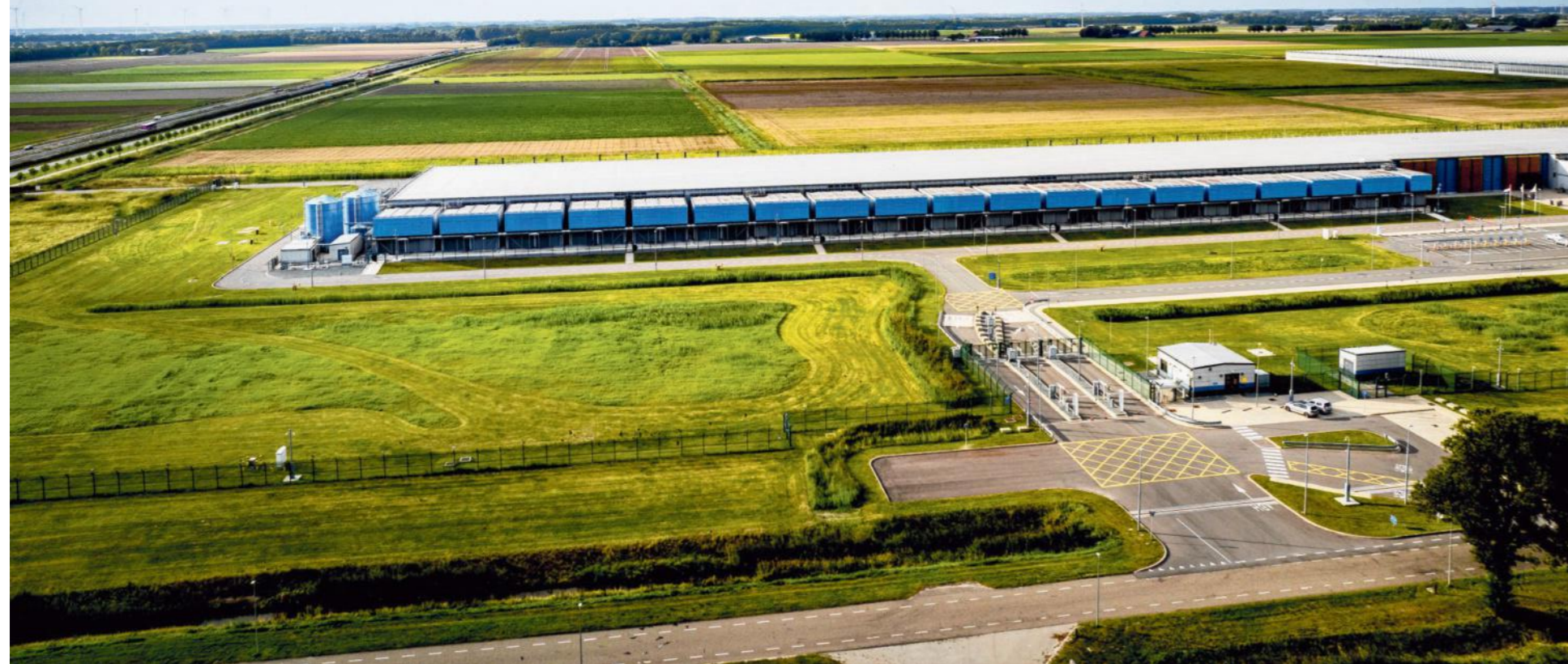
Een Google-datacenter in Middenmeer. Zo'n volledig pakket applicaties aanbieden als Google of Microsoft kunnen de zeven Nederlandse cloudbedrijven nog niet. FOTO ROBIN UTRECHT/ANP
