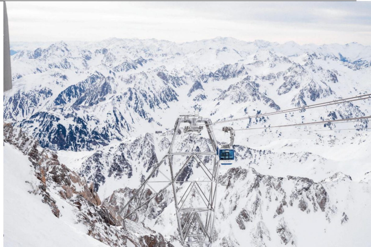
De kabelbaan naar de top.
