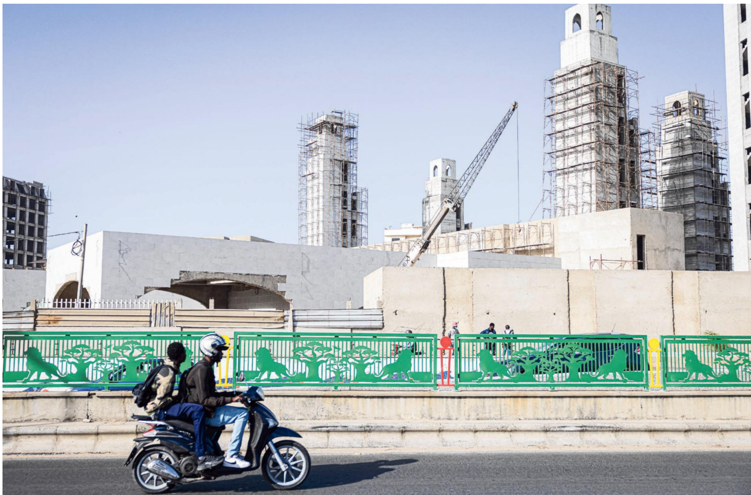
De Grande Mosquée Omarienne in aanbouw in de Senegalese hoofdstad Dakar. De bouw ervan ligt al twee jaar stil. FOTO PATRICK MEINHARDT/AFAP
