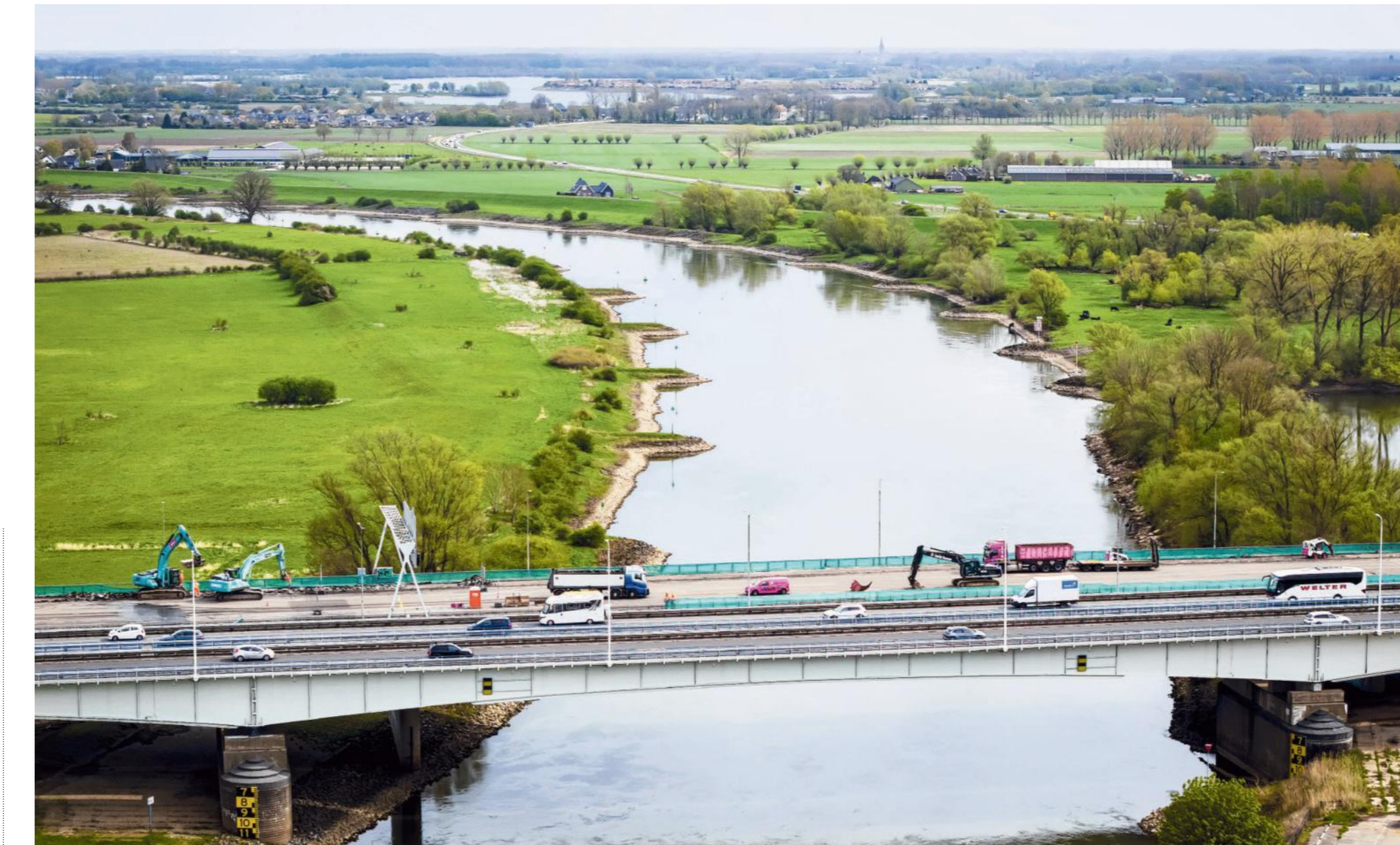
De betonnen IJsselbrug in de A12 bij Arnhem wordt gerenoveerd. FOTO SEM VAN DER WAL/ANP
