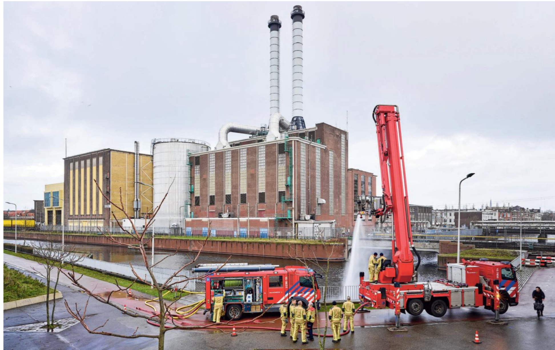
Energiecentrale De Verademing in Den Haag. FOTO WALTER HERFST
