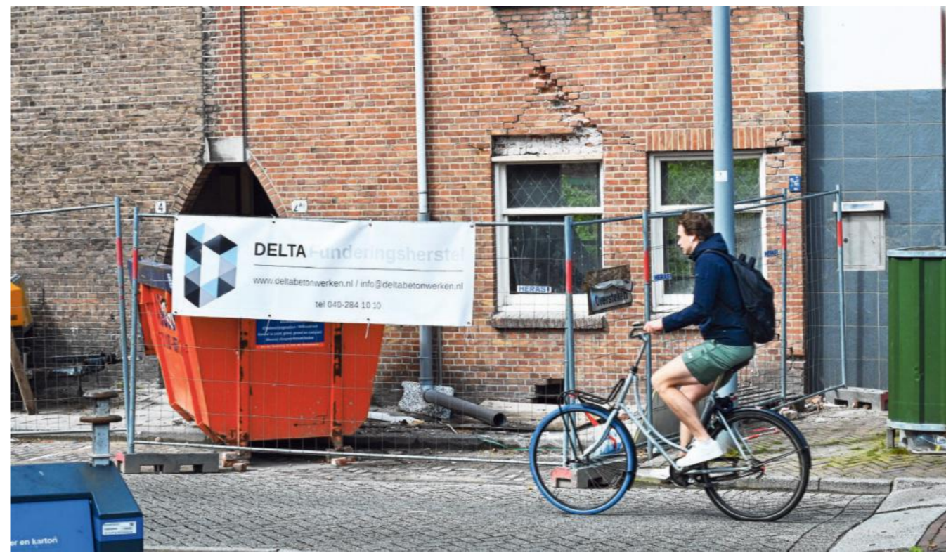
Funderingsherstel in Rotterdam. Onder: schade door paalrot in de wijk Kleiweg in Rotterdam. FOTO'S ROBIN UTRECHT EN PETER HILZ/ANP
