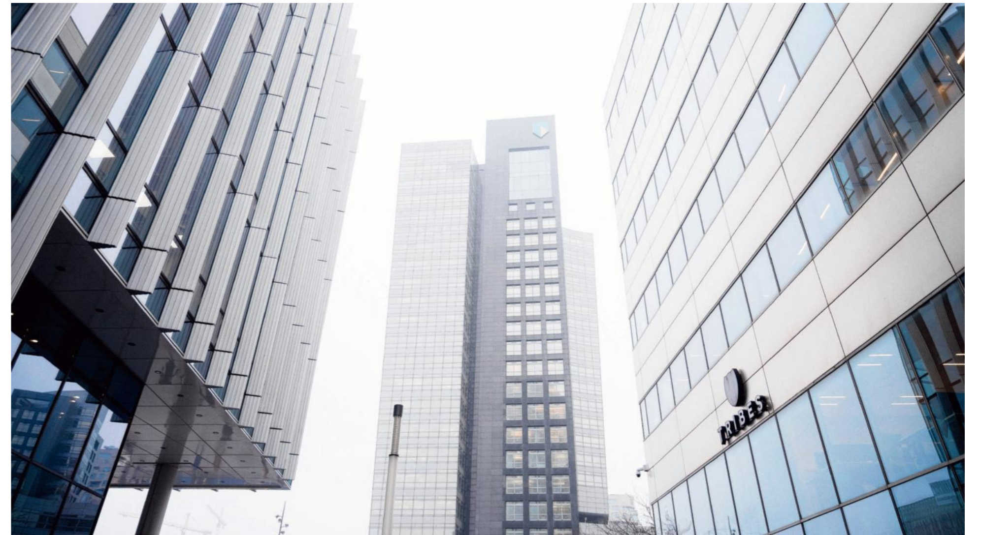
Een foto van het hoofdkantoor van ABN Amro aan de Amsterdamse Zuidas. FOTO ZARA NOR
