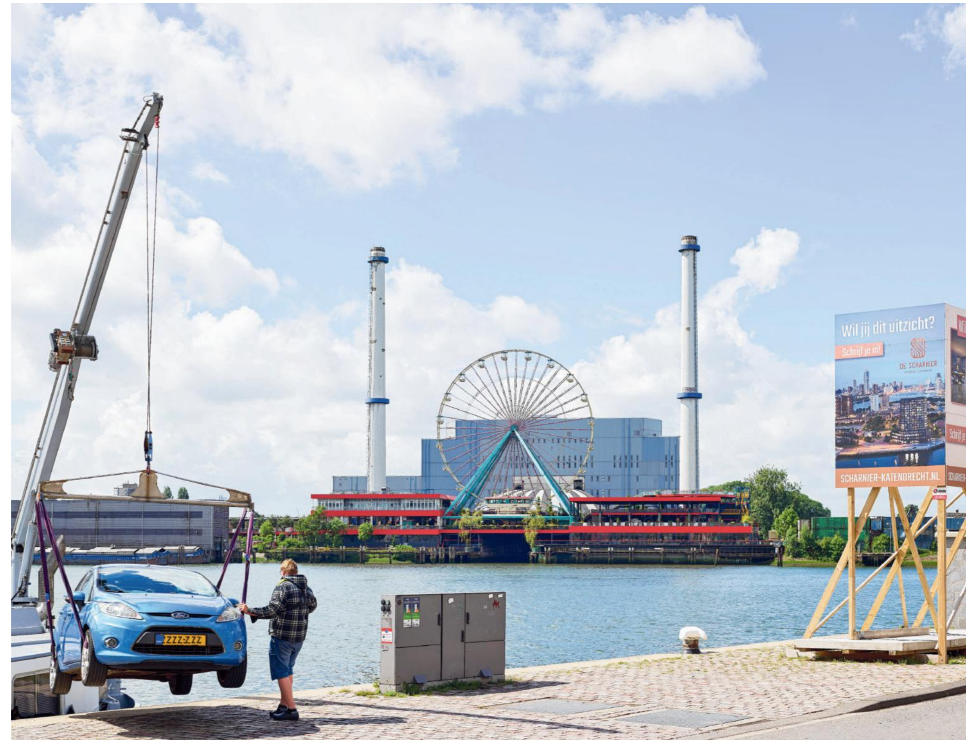
Spelen bij Beelen is een attractiepark in aanbouw op het terrein van de voormalige AVR-verbrandingsoven in Rotterdam-Zuid.
