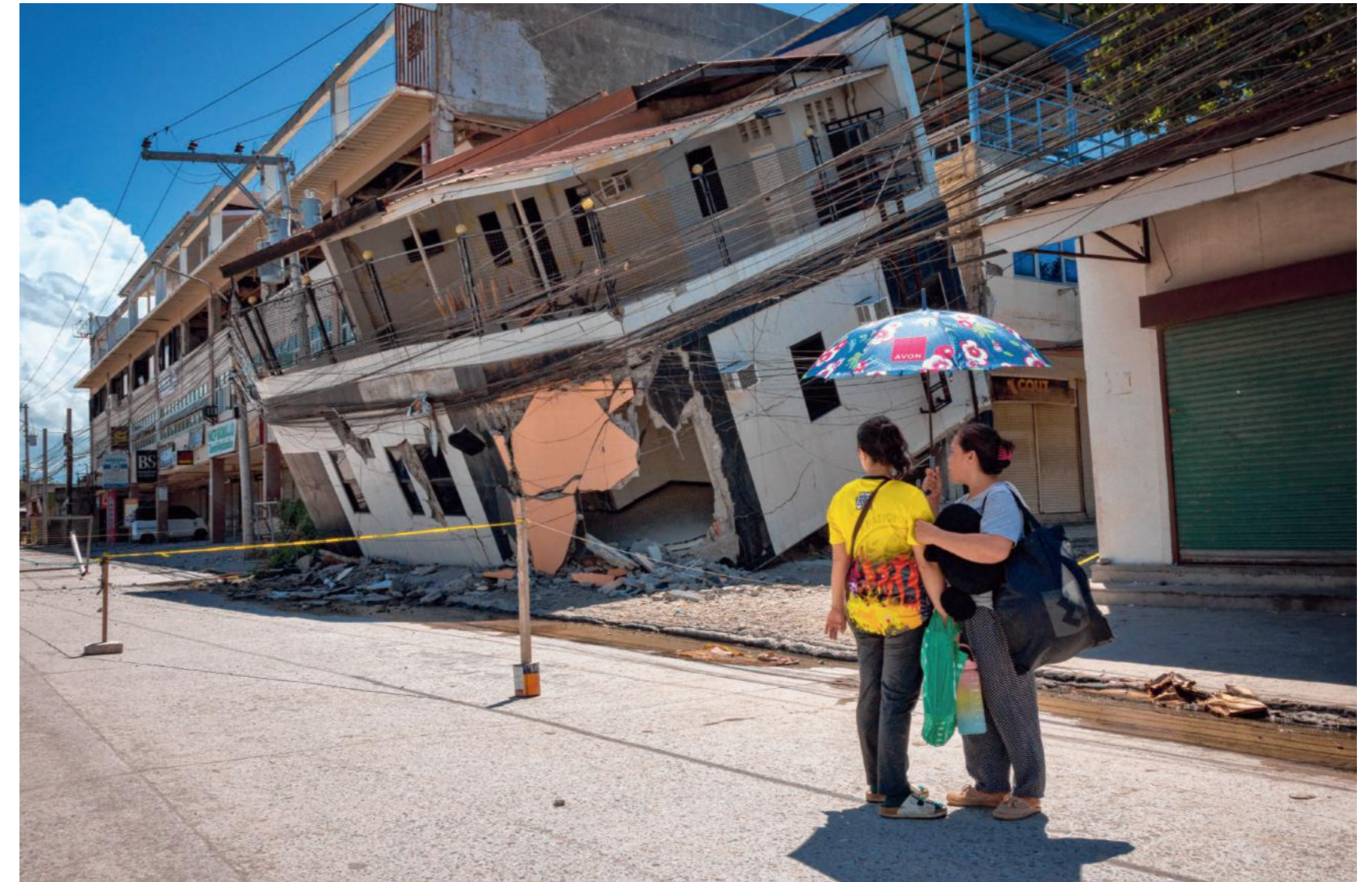
In de zuidelijke Filippijense stad General Santos staan mensen voor een door de aardbeving ingezakt gebouw. FOTO EZRA ACAYAN/GETTY IMAGES
